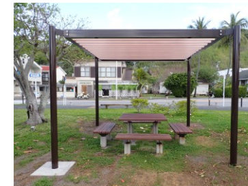
休憩施設の新設(大村中央地区)
