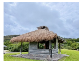
休憩施設の改修(大村中央地区)
