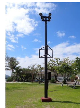
投光器の更新(大村中央地区)
