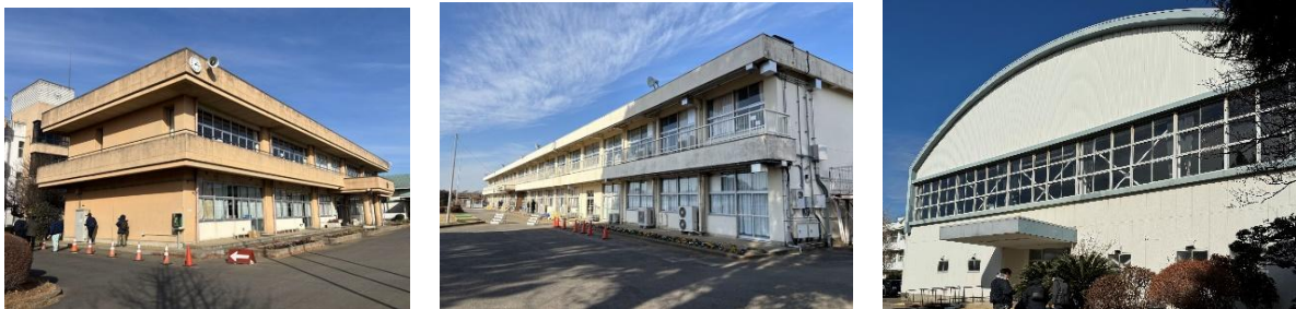
写真 I-1. 2. 3 建物調査を実施した校舎の例
