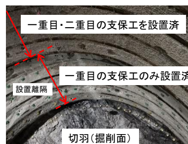
二重支保工の現場適用状況
