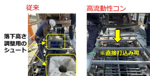
図-2 高流動性コンクリートの使用による打込み作業の改善状況
