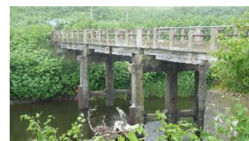
▲戦中～40年代、RC橋や鋼橋の代替として北海道内で広く活用
