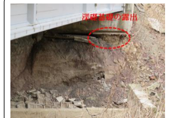
令和6年能登半島地震での橋台部の変状事例
