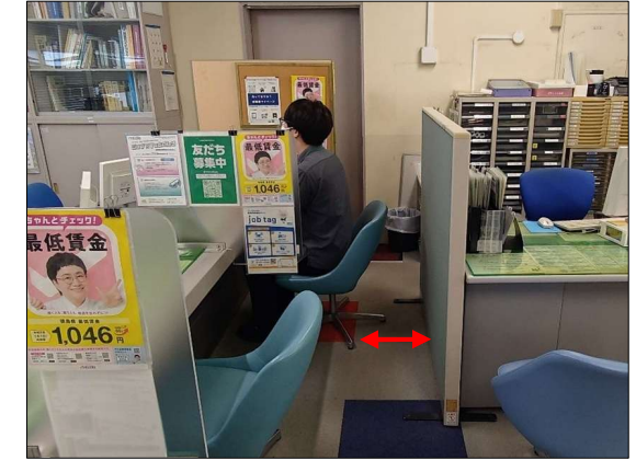
1階事務室・窓口 来庁者が訪れる窓口エリアの通路・受付部分等が狭く、移動が困難であるなどの課題がある。
