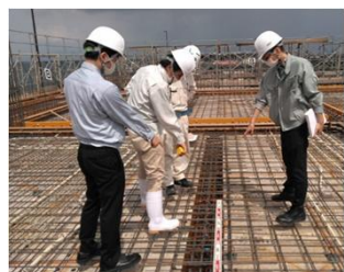
(従来) マーキング、メジャーの設置
