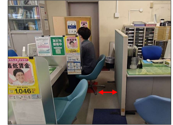
1階事務室・窓口 来庁者が訪れる窓口エリアの通路・受付部分等が狭く、移動が困難であるなどの課題がある。
