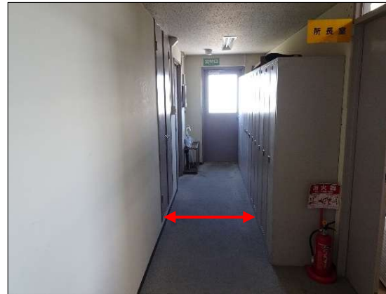
2階廊下 ロッカーを設置する面積が不足しており、通路部分に仮置きしている状態。
