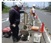
（貫入試験による調査）
