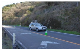
MMS※1を活用した 斜面・のり面点検
