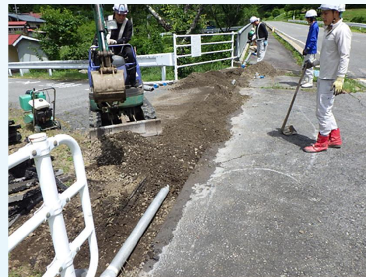
復旧作業の様子（木曽町）
