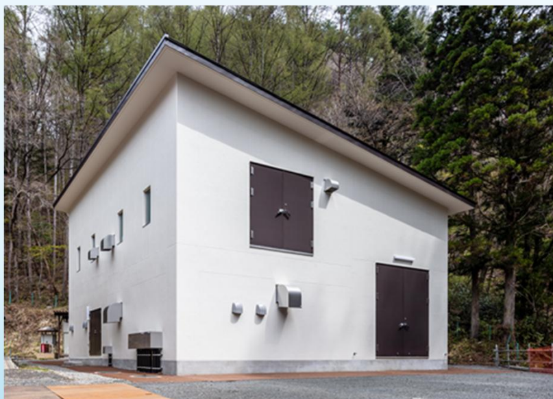
浄水場の新設（木曽町）
