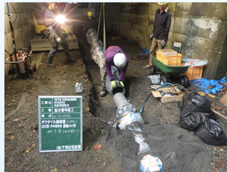
耐震管の布設（木曽町）
