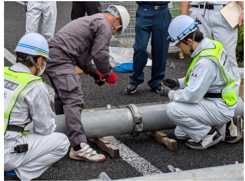
管路応急復旧訓練
