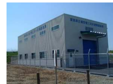
共用備蓄倉庫
