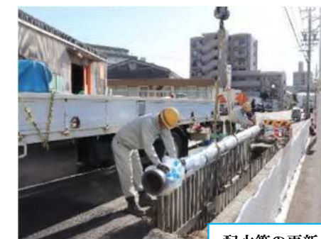
配水管の更新
