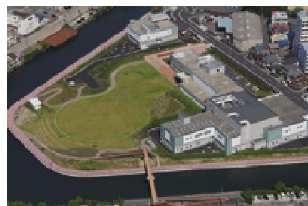
露橋水処理センター
