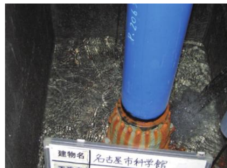
利用水槽の内部
