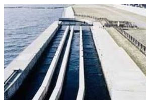
呼び水式魚道
