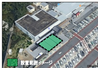
設置予定箇所(遠景)
