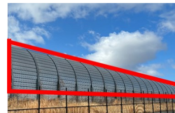
高速道路内の遮音壁(外壁) NEXCO西日本より提供
