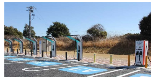
EV充電器の設置
