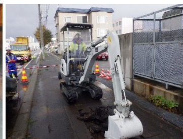
電動建機を用いた工事の様子
