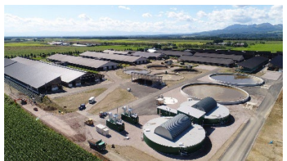
バイオガス発電 (北海道上士幌町)
