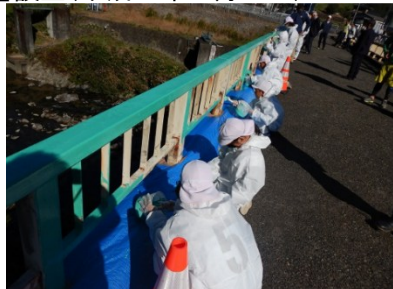
小学生の歩道橋塗装体験 (岐阜県)
