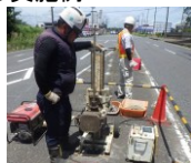
(貫入試験による調査)
