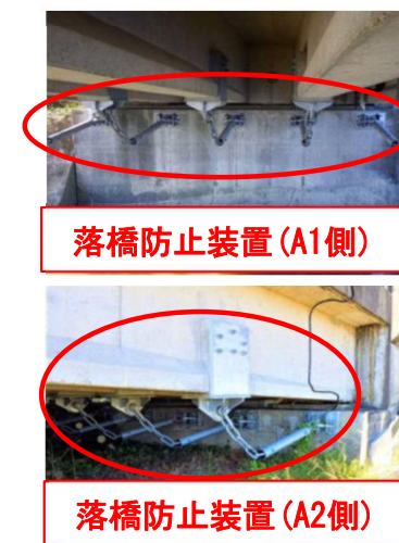
〈施工完了（拡大）〉
