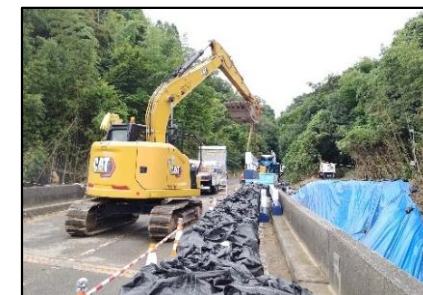
緊急復旧(橋台背面の崩壊箇所) 【TEC-FORCEパートナー】 〇
