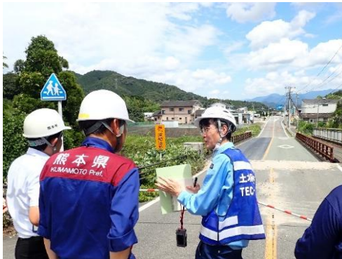
▲7月29日_国道218号 新山崎橋の調査状況
