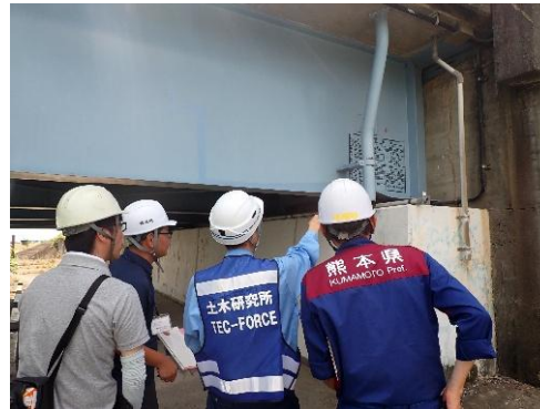
▲7月30日_県道八代鏡線 新前川橋の現地調査
