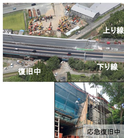
下り線応急復旧後
