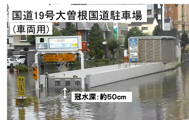
・大曽根国道駐車場(名古屋市)の状況
