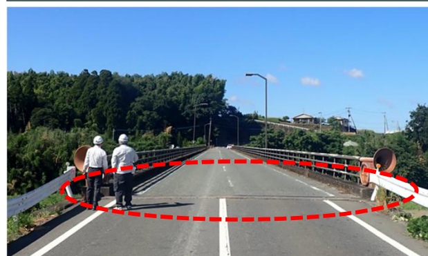
上部構造が直角方向へ移動
