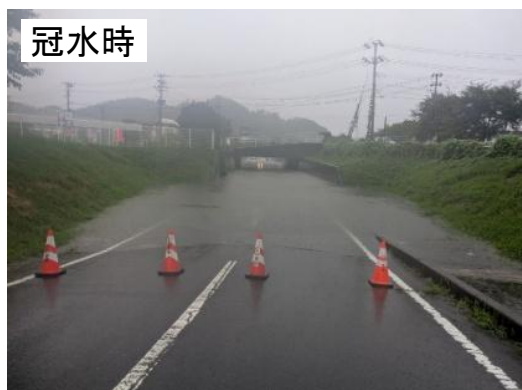
・福島県いわき市 アンダーパス冠水状況
