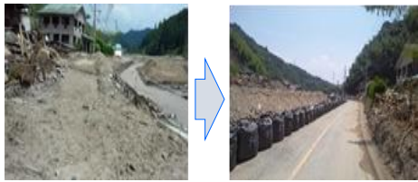
災害時の道路啓開
