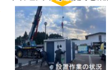
設置作業の状況
