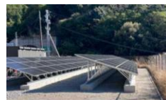
太陽光発電施設の設置
