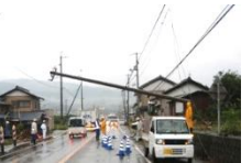
沿道の電柱の倒壊による道路閉塞
