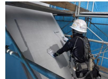
塗替塗装状況
