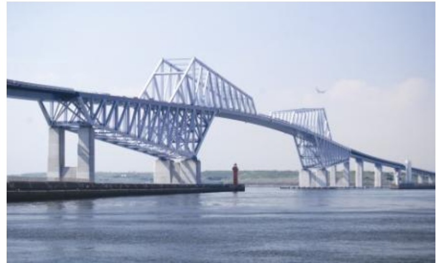
東京ゲートブリッジ(2012)
