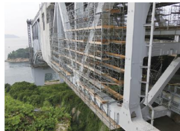
仮設足場設置(トラス桁)
