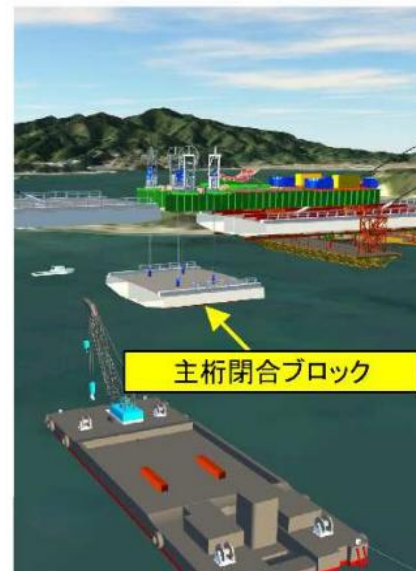
主桁の直下吊り架設～閉合シミュレーション (施工計画審査の質向上)
