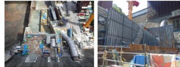
放流管設置中(令和8年8月)
