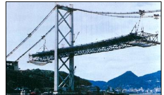
関門橋建設状況 (1972年(昭和47年))
