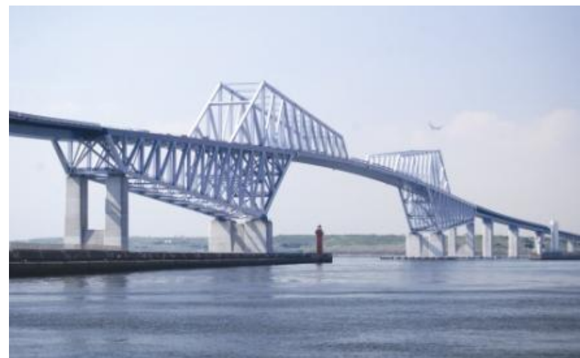
東京ゲートブリッジ(2012)
