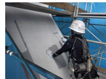
塗替塗装状況
