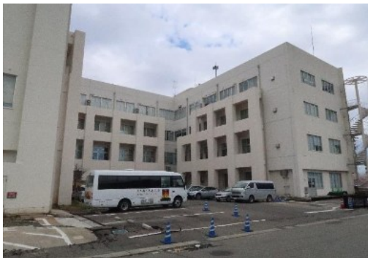
(a) 補強外観（地上部分のみ）
