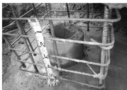
図3.3 パイルキャップの増し打ちによる杭頭の補強 21)
