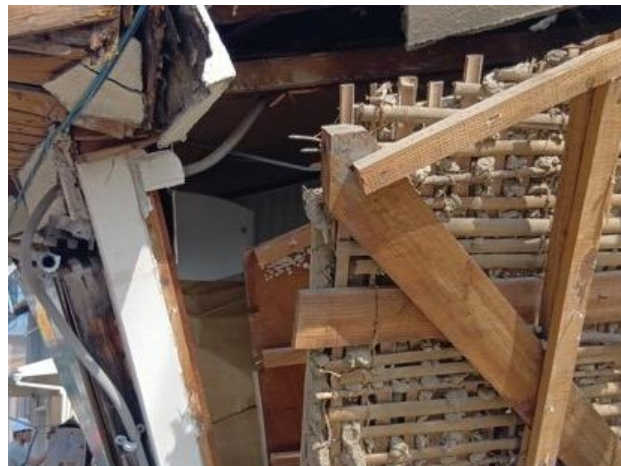
土壁+筋かい（端部は釘留め）
