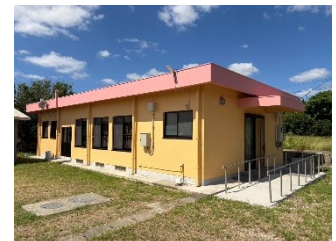
避難所の改修(伊仙町)
