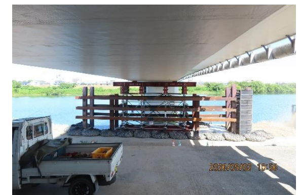
ベントによる待ち受け対策 (箱桁内部の応急対策も実施)
