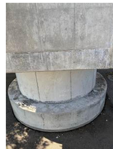
P3橋脚は変状なし (前回被災、対策済み)
