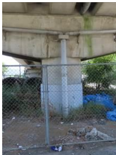
P2橋脚は変状なし (前回被災、対策済み)
