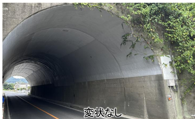
田浦トンネル(国道3号)
