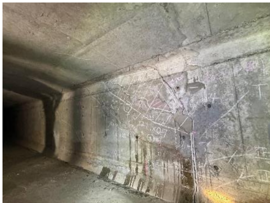
箱桁内面にも下床版から上床版まで全周にひび割れ
