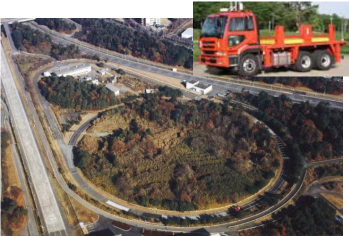
実大の供試体による促進載荷試験 実大の舗装の施工が前提となっており、性能評価のハードルが高い。
