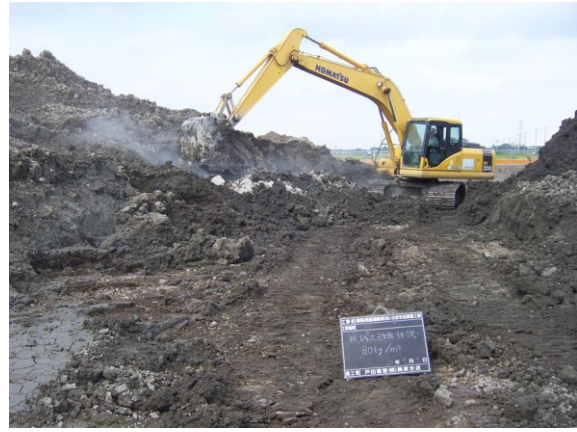
建設汚泥の改良
