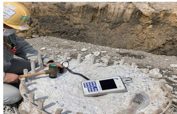
既存杭の健全性の調査
