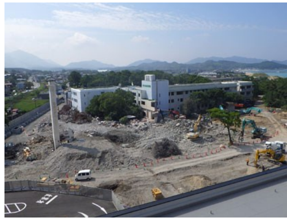
建築物の解体
