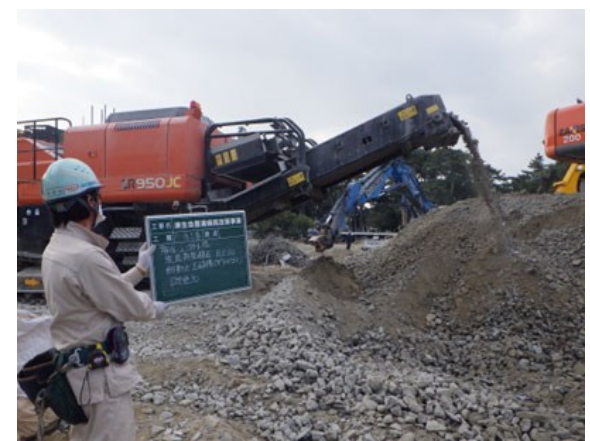
コンクリート塊の粒度調整
