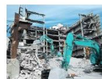
ビルの解体工事等
