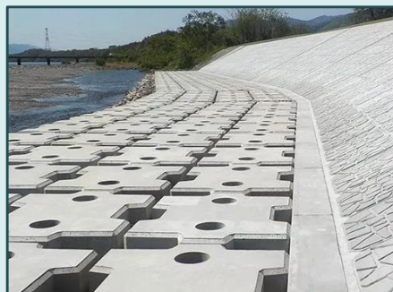
根固めコンクリート
