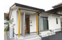
空き家の改修(お試し居住施設)
