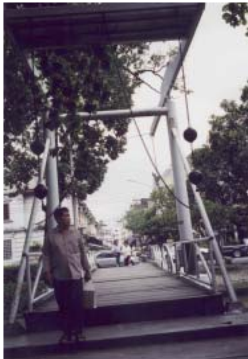
写真25 ロート水路に架かる跳ね橋(バンコク)
