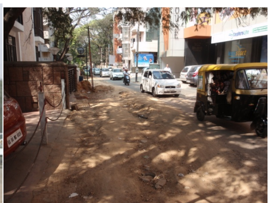
写真 一般道路の路肩は通常未整備
