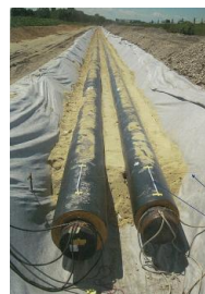
導管の断熱処理状況
