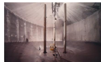
温水貯留タンクの内部
