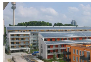
太陽光パネルの設置状況
