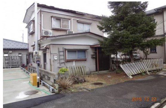
解体前の空き家A (2015年)
