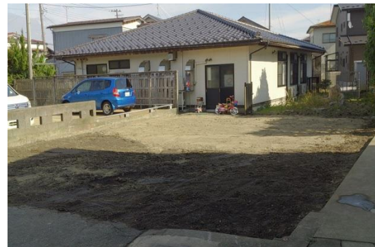
空き家Aの解体後 (2018年)
