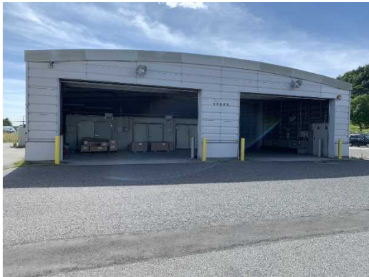
C. 冷凍冷蔵庫棟(保税：広島国際空港㈱)
