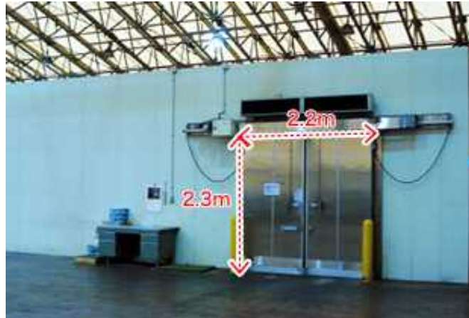
図 46 冷蔵倉庫(C. 第2国際貨物上屋) 76
