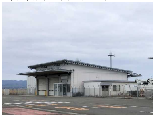
入居していた貨物利用運送事業者が撤退し、現在は使用されていない
