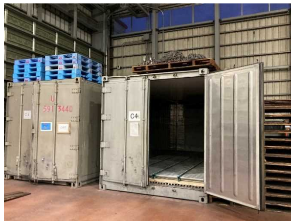
図 45 海上コンテナを利用した冷凍庫・冷蔵庫(B. 第1国際貨物上屋) 75
