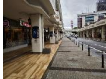
写真 8-3 市道南 2-2 号線の様子
