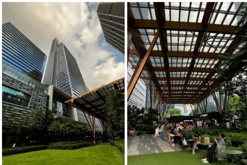
▲都心部の TOD の事例の一つ、タンジョン・パガー駅の全景（左）と駅上に広がる公共空間（住民の要望により設置された）（右）
