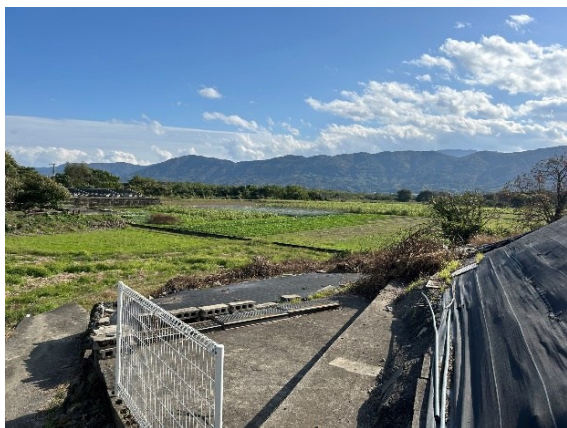
写真 2-10 災害危険区域内的の農地 (日開谷川下流付近)
