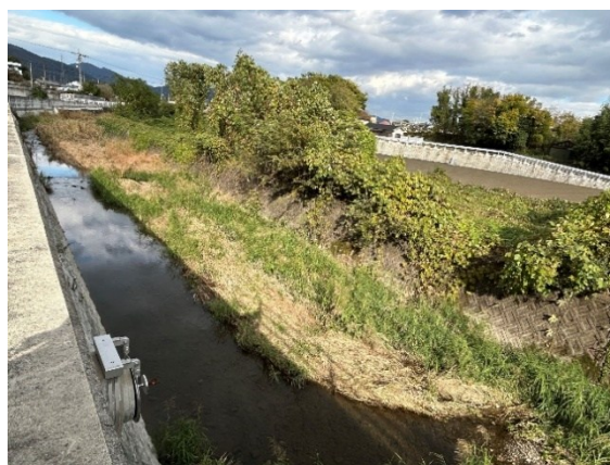
写真 2-11 災害危険区域内的の農地とかさ上げされた市道 (松崎谷川下流下流付近)
