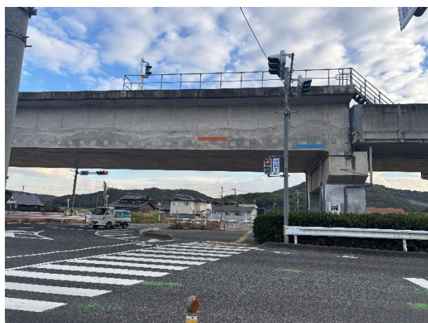
写真 4-4 小田川の堤防高(5m)を示すオレンジライン (井原鉄道高架)
