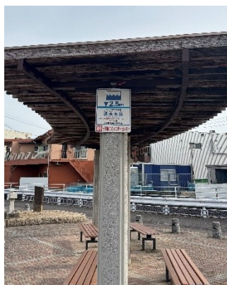
写真 2-6 昭和 47 年 7 月豪雨の浸水深を示す看板
