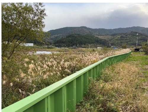
写真 2-12 日高村が整備した輪中堤
