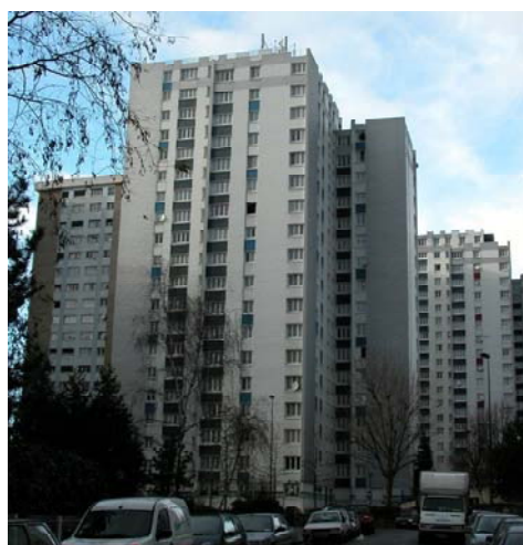
図表 3-I.34 写真：取り壊し予定高層住棟
