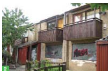
図表 3-II-14 改修前の住宅
