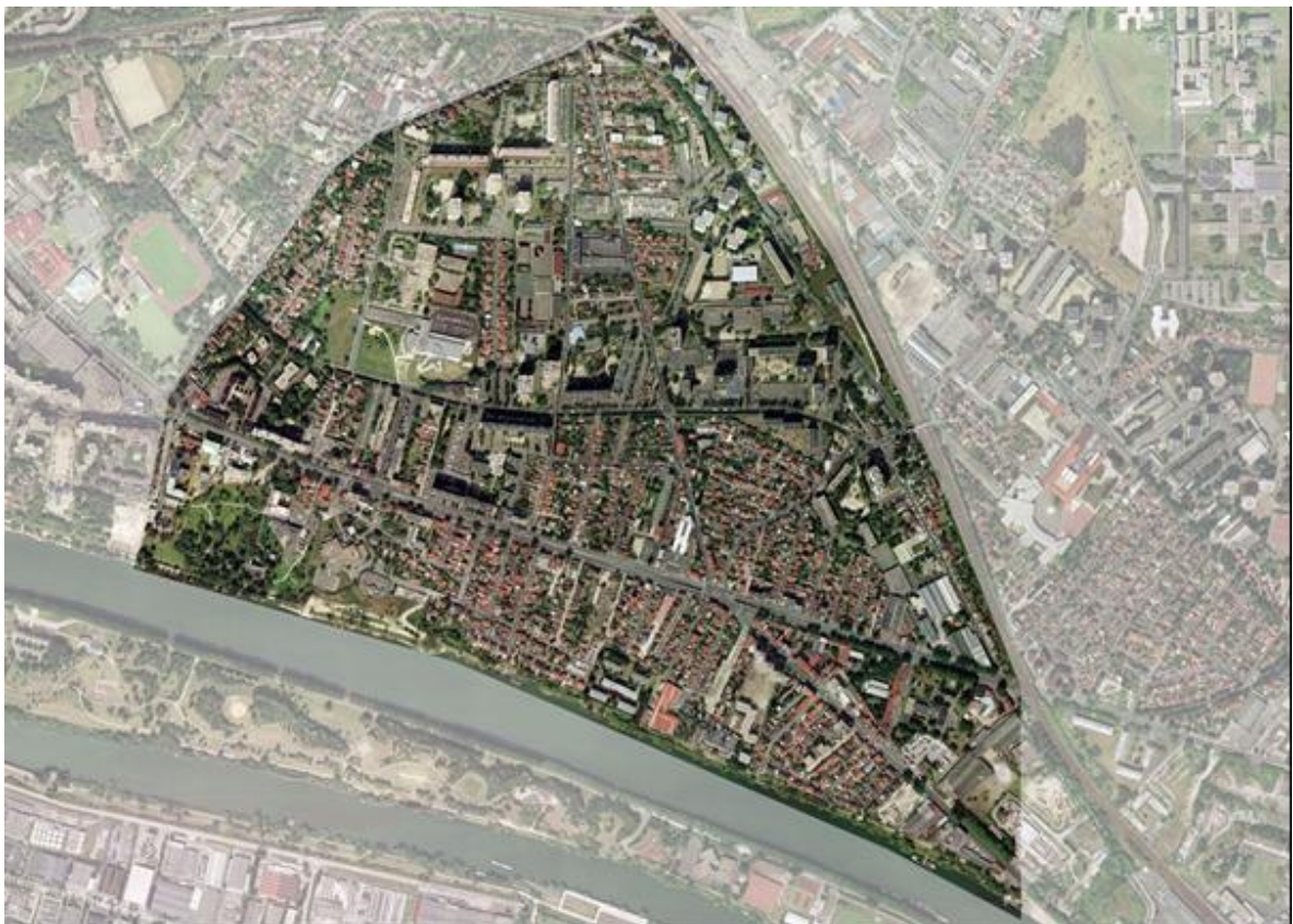
図表 3-150 写真:S 地区航空写真
