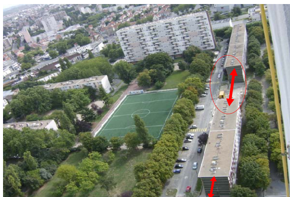
図表 3-I.60 写真: ストラスブール通り一部解体 (整備後)
