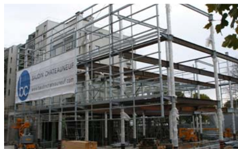
図表 3-I.32 写真:工事中の メディアテック・センター(2009年10月)
