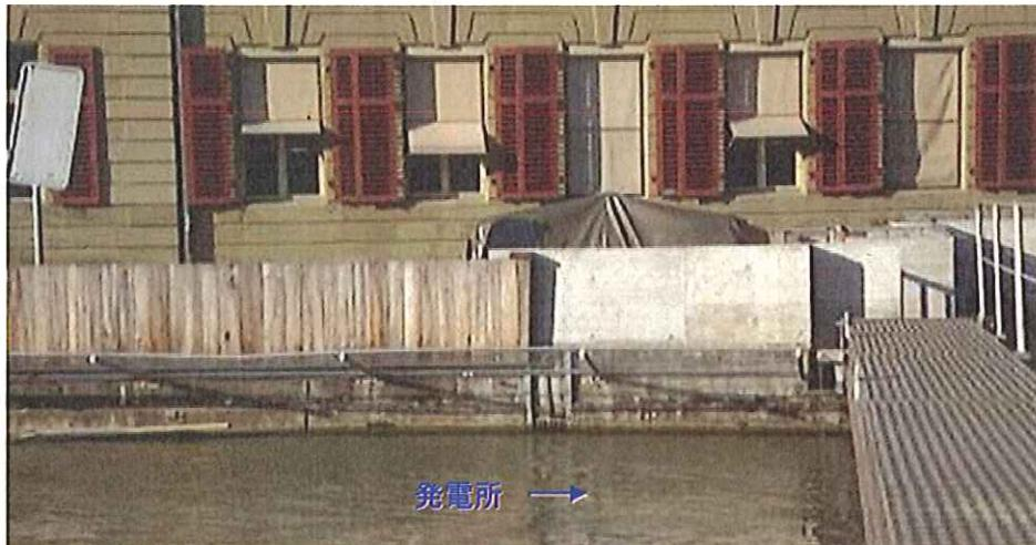
(右側がコンクリートの堤防、左側が木製の仮設置の堤防)
