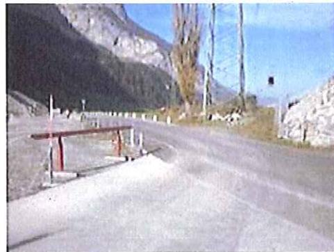
ロイス川に流水を戻す部分では、アウトバーンと一般道路が立体交差している。防災時には、水が一般道路を通って上流部に流れ込まないように立体交差部の下に可動式の壁（横に設置された倉庫に保管）を設置することとなっている。
