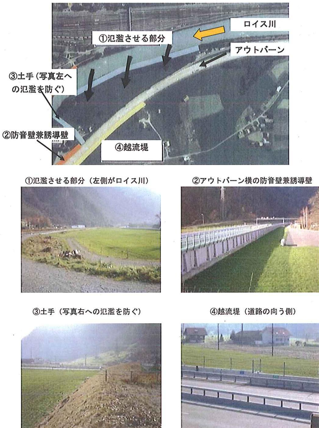
図表 3-125 蛇行下流部の対策(ロイス川に流水を戻す部分)
