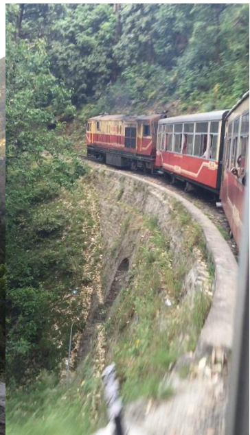
写真19 橋等の構造物が多い。
