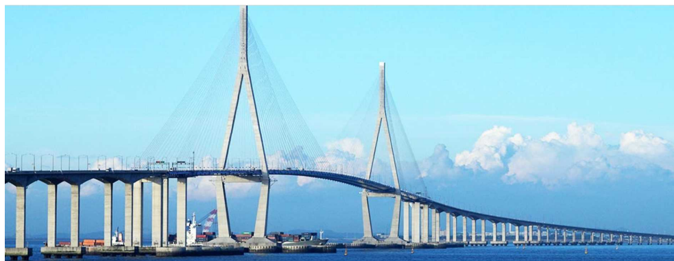
図 1 PPI で建設された仁川大橋 出所：仁川特別市
