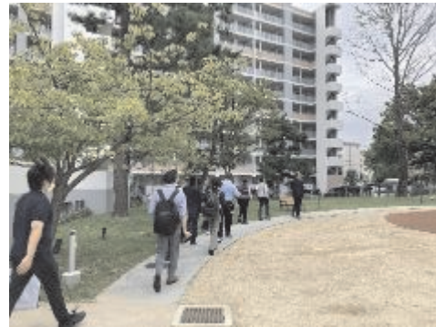
写真 5 建替え後の住棟及び屋外空間の視察
