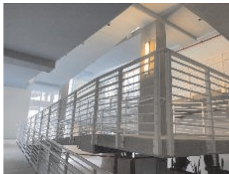
写真 18 屋内に設置されたスロープ (最上階まで通じている)
