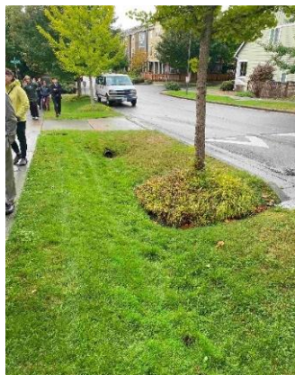
写真1 バイオリテンションの機能を有する施設 (左：住宅地内のバイオスウェル、右：車道と歩道の間のバイオスウェル)
