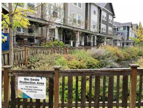
住宅団地内のバイオスウェル (ハイポイント)
