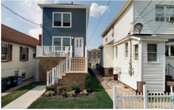
写真 10 2013 Flood Text で再建された住宅（ニューヨーク市資料より引用） 80
