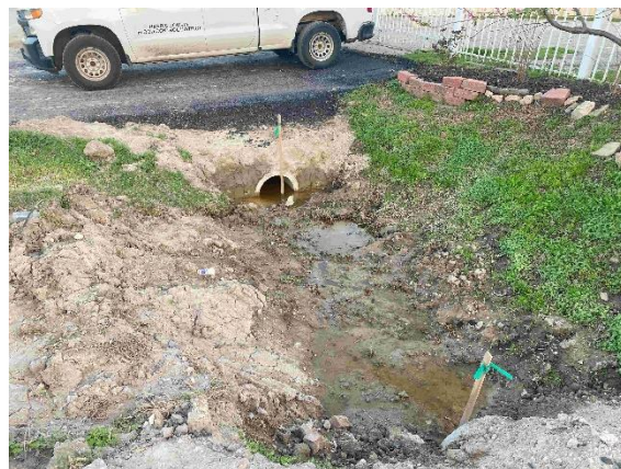
写真6 道路脇の側溝の工事箇所（筆者撮影）
