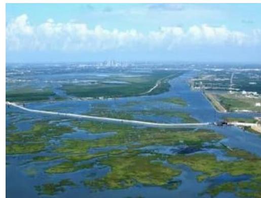
写真 1 IHNC ボーン湖防潮堤全景 17
