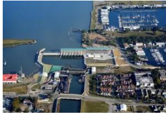
写真 2 17 番街運河ポンプ場全景 19
