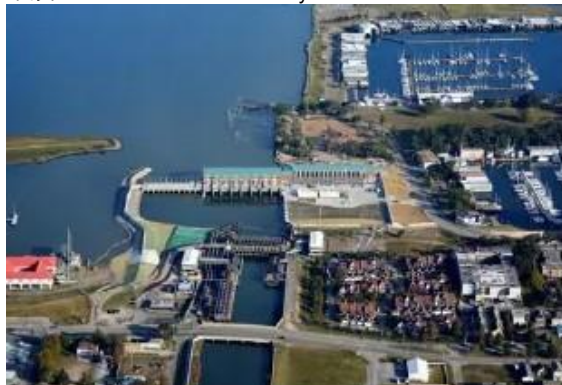
工兵隊が整備したポンプ場 (17番街運河ポンプ場)
