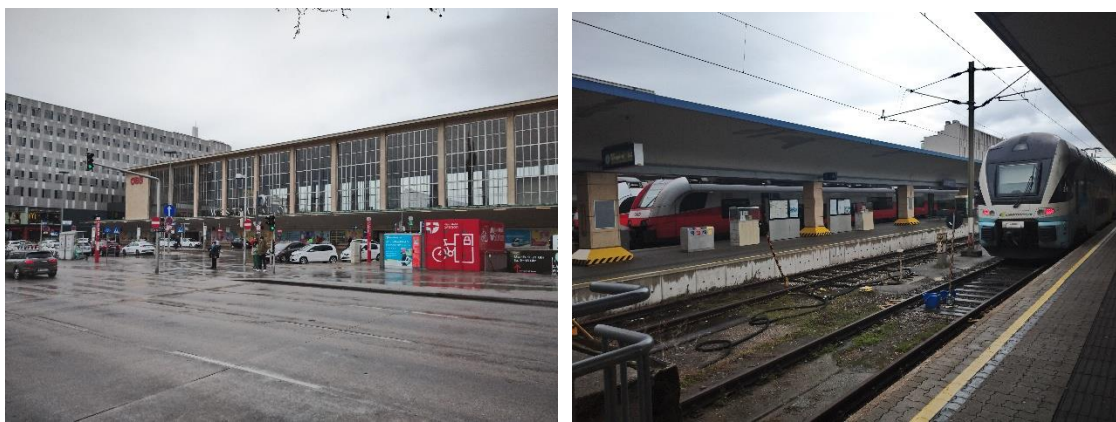
図 17 VAO のある Wien Westbahnhof
